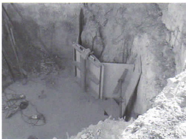
Préparation d'un coffrage sur l'un des piliers au Bloc 1.
