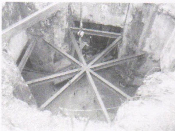
L'étoile de poutrelles au Bloc 1.
