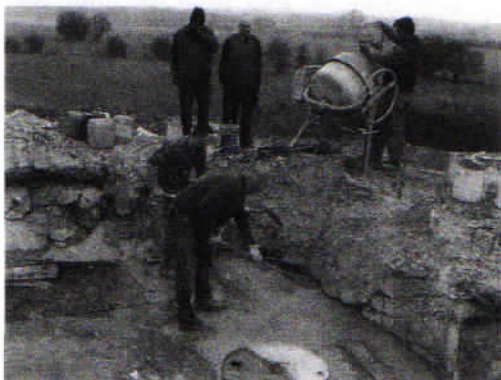
Le bétonnage a commencé sur le dessus du Bloc1.
